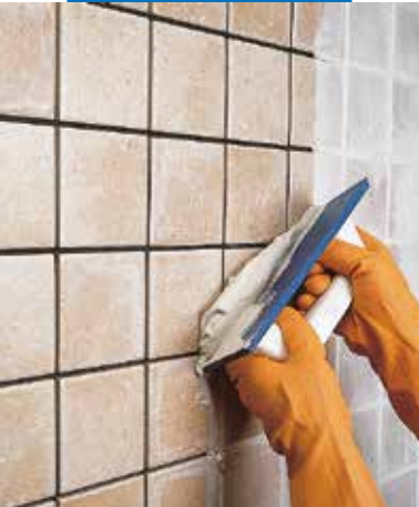
Stuccatura di rivestimento in monocottura con spatola
