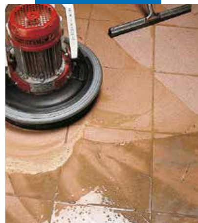
Finitura di pavimento in porcellanato con monospazzola e racla
